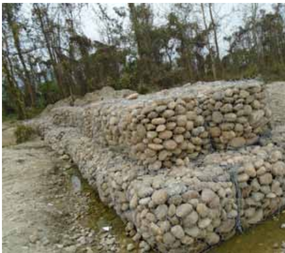
निर्माण सम्पन्न तटबन्धन
